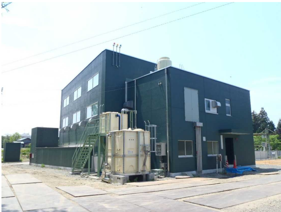
(下川原ポンプ場)
