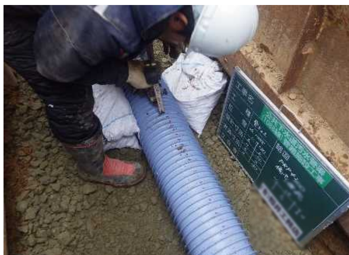
(汚水管渠敷設の様子・塩ビ管)
